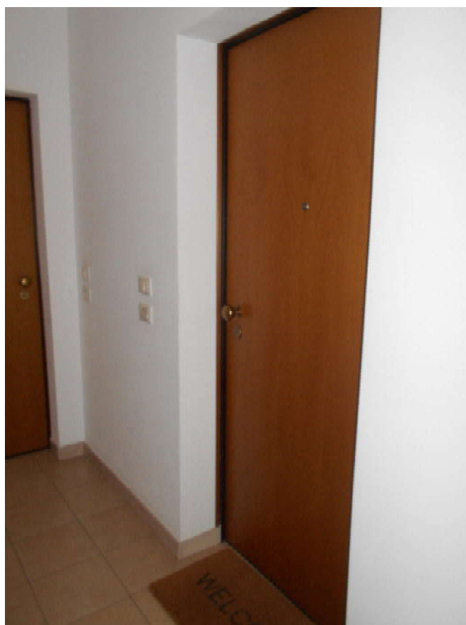
Foto 10: porta d'ingresso dell'appartamento
