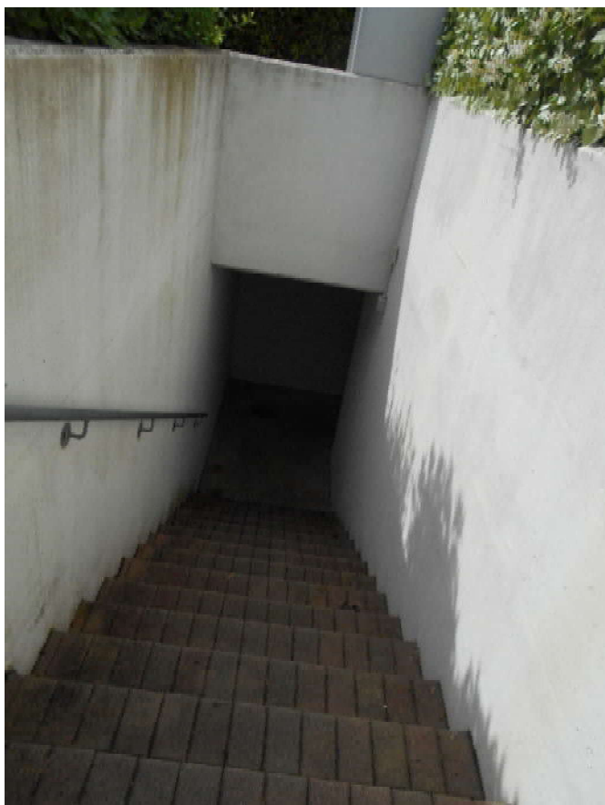
Foto 7: scala esterna di accesso all'autorimessa interrata
