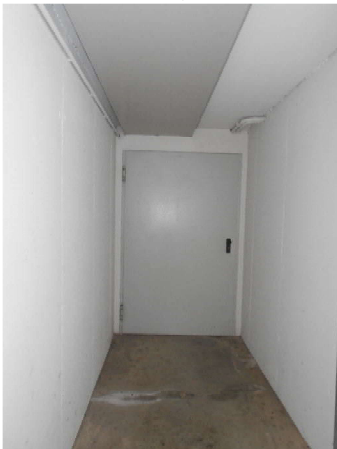
Foto 27: corridoio comune piano interrato, porta di accesso all'autorimessa
